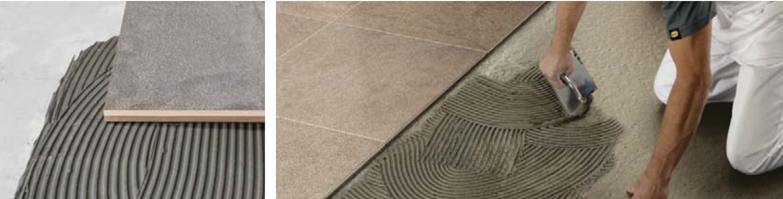
POSA TRADIZIONALE CON AUSILIO DI COLLE Conventional laying with adhesives. Pose traditionnelle avec de la colle. Traditionelle verlegung mit Klebstoff. Colocación tradicional con empleo de adhesivos. Традиционная укладка на клей. 传统的使用粘黏剂铺贴
