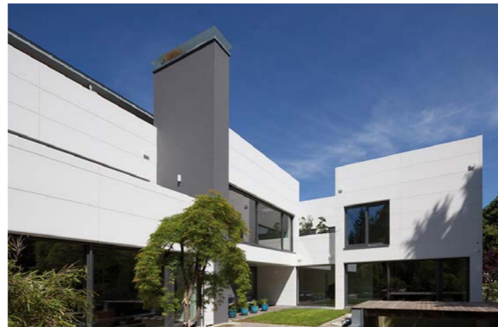
Architetto: Dipl.-Ing. Volker Wiese, Berlin - Kaden Klingbeil Architekten | Realizzazione: Kiebitzberg GmbH & Co.KG - Kloepfer Surfaces | Foto: Dirk Wilhelmy
