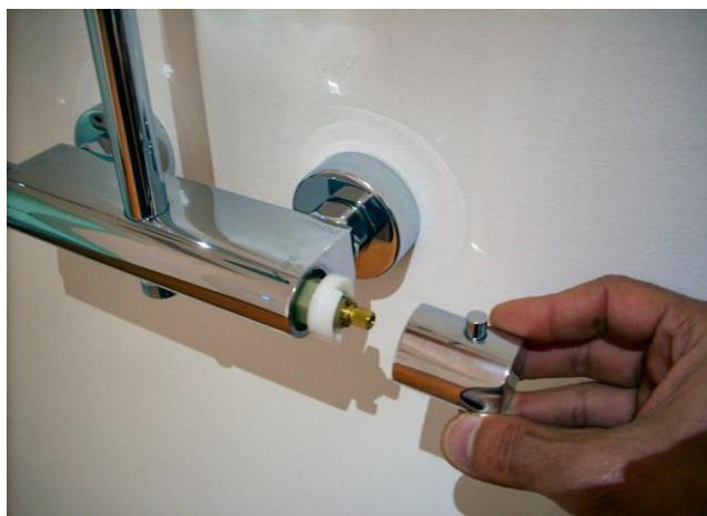
Inserire la manopola con il pulsante rivolto in alto e con l'indicatore della temperatura allineato alla tacca presente sul miscelatore SENZA ruotare l'asta della cartuccia.
