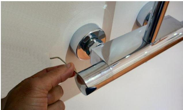
Bloccare la manopola del deviatore avvitando il grano con chiave a brugola da 2 mm.
