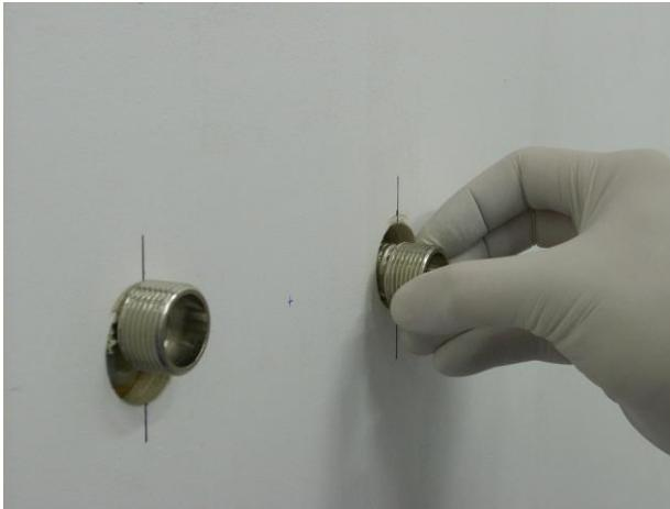
Avvitare i raccordi eccentrici agli attacchi dell'impianto, utilizzando canapa o simili per realizzare la tenuta idraulica.
