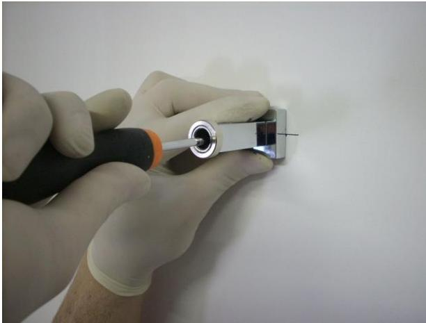
Inserire il tassello nel foro e fissare il supporto alla parete serrando la vite.
