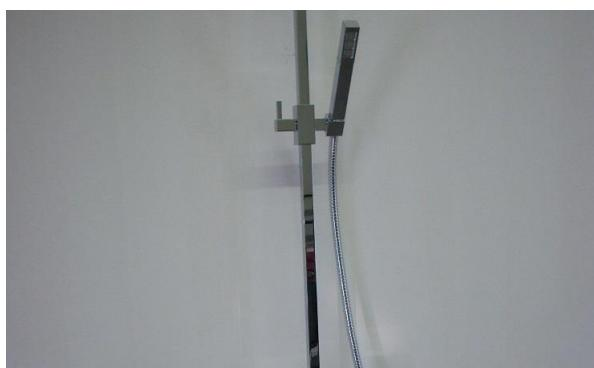
Avvitare il soffione all'attacco da 1/2" del tubo.
