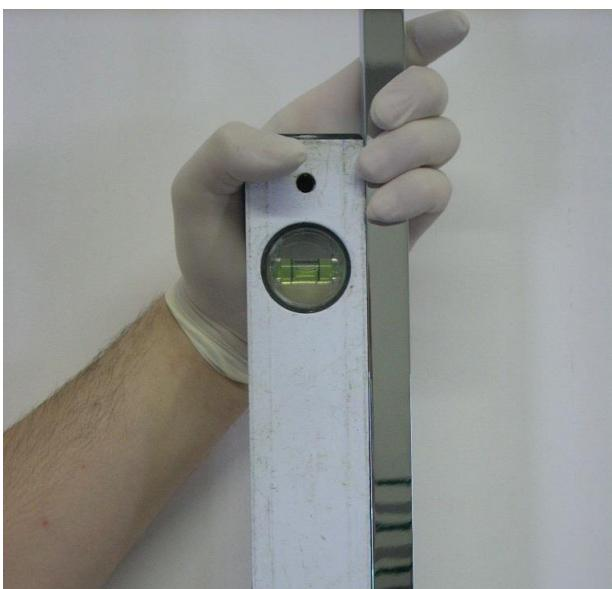
Con l'ausilio di una livella posizionare correttamente in bolla la parte superiore della colonna.
